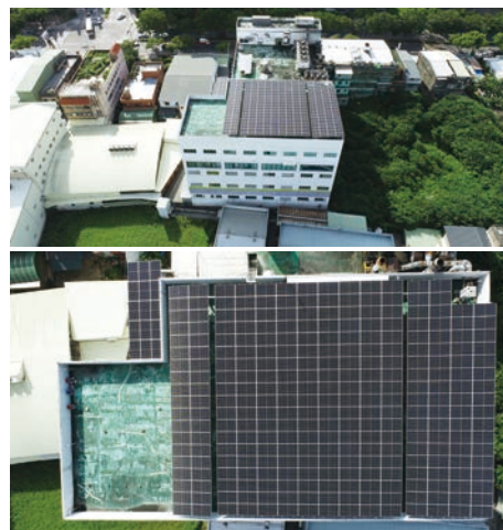
台灣尖點太陽能光電設備
